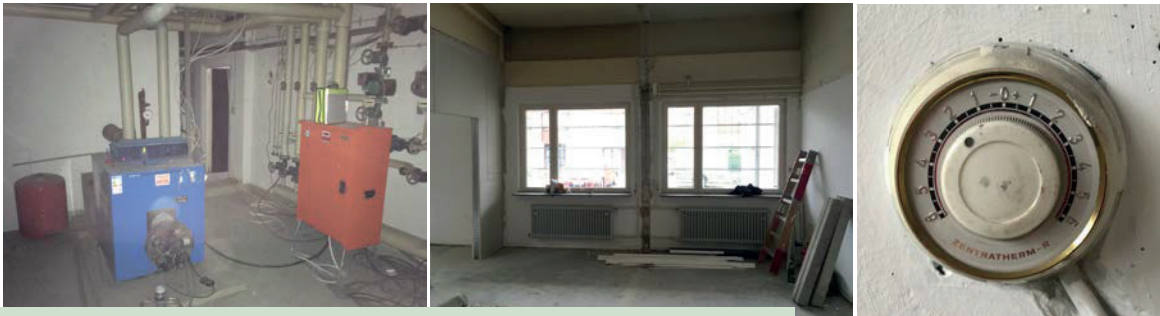
Technik aus dem letzten Jahrtausend: Die alte Ölheizung wurde entfernt
